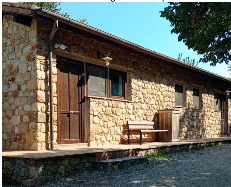
Foto 2: Posto di guardia notturno DOPO L'INTERVENTO
